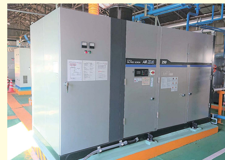
多賀事業所に導入した高効率なエアーコンプレッサー自動制御システム
