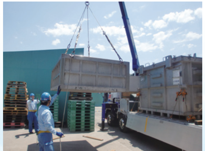
PCB廃棄物の搬出作業
